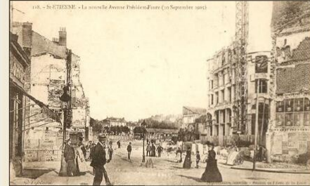
L'avenue de la Libération en cours de construction.
